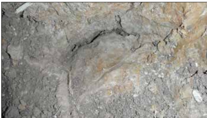
Obr. 6 Šmyková plocha vo výkope, profil 1, Nitrianske Hrnčiarovce
